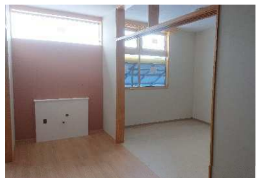
特養棟 多床室内装工事が進んでいます。
